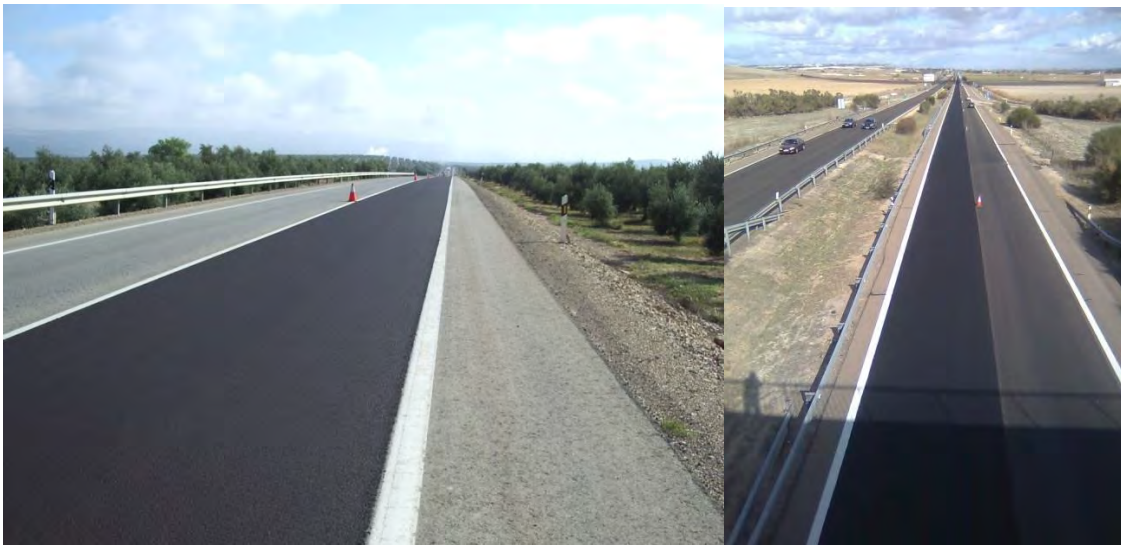
Figura 3. Aspecto final del microaglomerado en frío en autopistas
