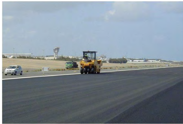
Figura 5. Compactación del microaglomerado en frío
