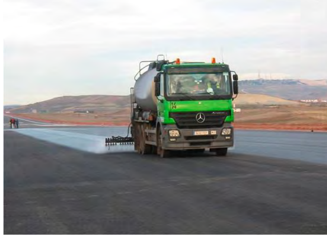
Figura 4. Aplicación del riego de adherencia
