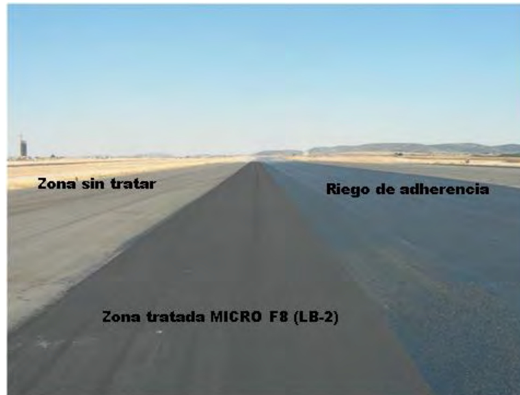
Figura 6: Las 3 zonas de la ejecución, antes, durante y después del tratamiento
