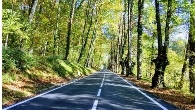
(Aspecto de la mezcla templada reciclada al 80% de RAP + 20% de árido siderúrgico)
