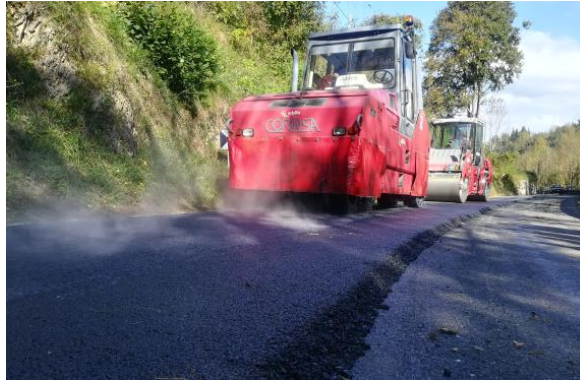
(Detalle del tren de compactación)
