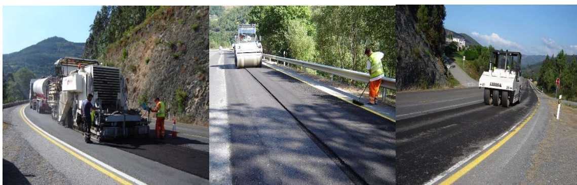
Foto 2: Ejecución del reciclado
