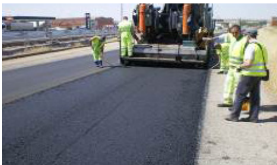
Extendido de una mezcla templada con 100% de material reciclado.
