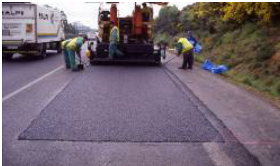
Extendido mezcla templada abierta en bacheo
