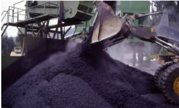
Acopio en planta
