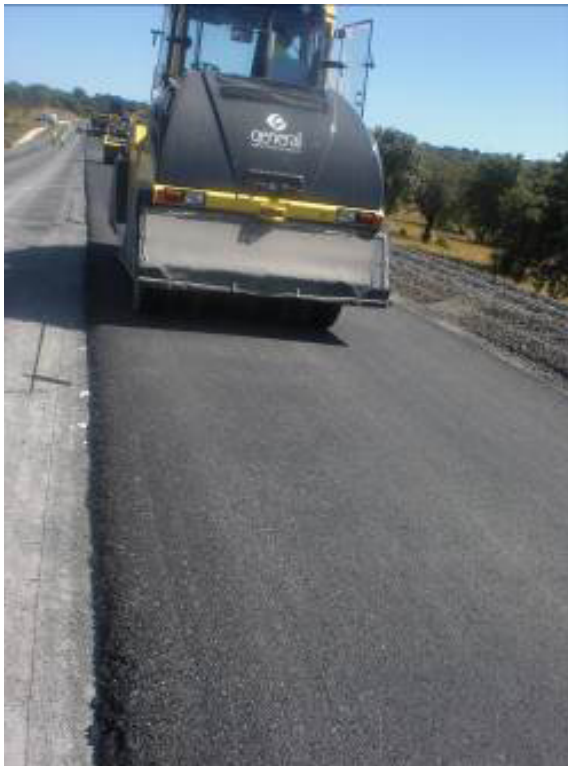
Extendido mezcla templada cerrada en intermedia
