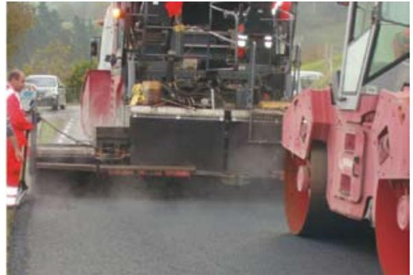
Fig. 5: Compactación de una mezcla templada GF12 con árido siderúrgico.
