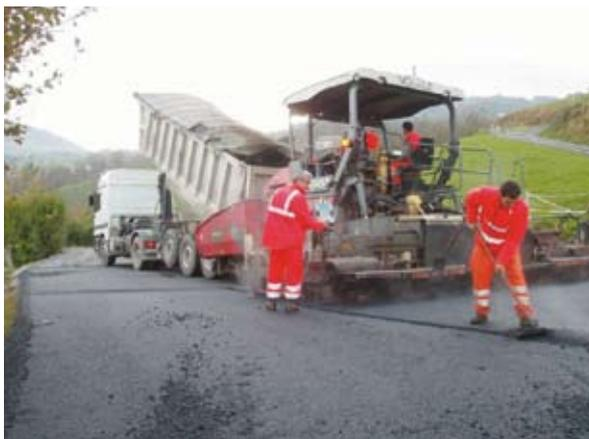
Fig. 4: Extendido de una mezcla templada GF12 con árido siderúrgico.
