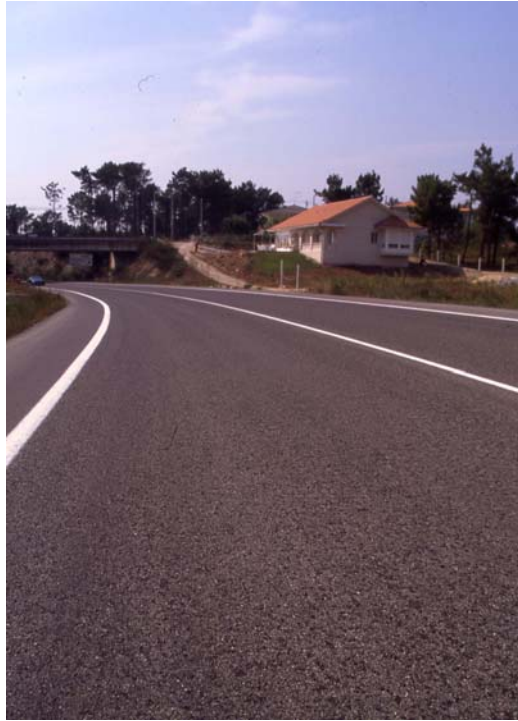
ASPECTO DE UN BUEN TRATAMIENTO SUPERFICIAL
