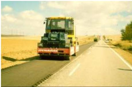
En general, las necesidades de compactación son mayores que las que se requerirían para la compactación de una capa de mezcla bituminosa en caliente del mismo espesor, especialmente los reciclados del tipo RFE-III. Ello se debe a que este tipo de materiales, al igual que las grava-emulsiones, son bastante “agrios” y con poca trabajabilidad, pues normalmente se busca trabajar con el mínimo posible de humedad al objeto de acortar el periodo de maduración.
