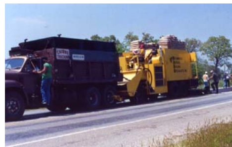
Máquina de tipo continuo de aplicación de microaglomerado
