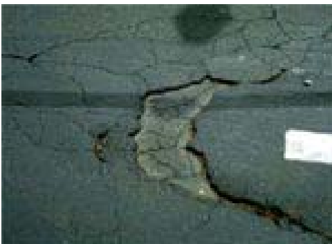
Pérdida de material, medias lunas, agrietamiento, etc. NO APLICAR
